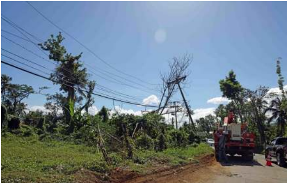
Nieuwe elektriciteitspalen worden geplaatst
